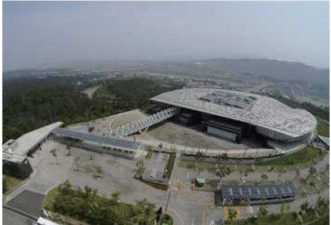
本館建築設計應用了七大設計精神，包括尊重環境地貌、契合自然風水、善用地方資源、重視家族觀念、順應時勢演變、堅持硬頸精神及積極精耕雨讀設計規劃，搭配有特殊設計之屋頂帷幕以減少熱輻射、空調節能設計及雨水回收再利用系統等節能減碳措施，充分表達尊重環境地貌及善用地方資源的設計理念。
