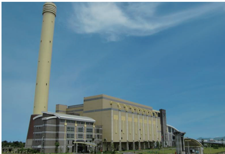
宜蘭縣利澤垃圾資源回收(焚化)廠全景
