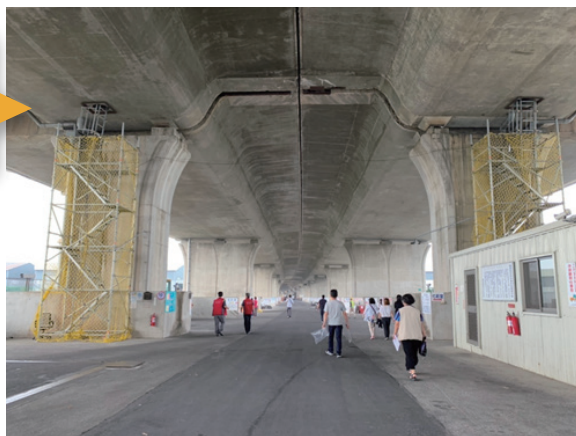
回收場位於國道4橋墩下，兩側為回收物堆置區，共計52類。因採回收物不落地方式進行分類，除快速省時，更確保回收動線順暢及路面乾淨，一改民眾對於回收場髒亂之印象。
