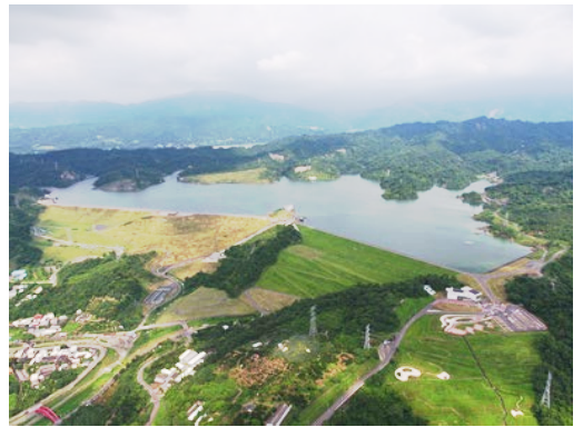
湖山水庫大壩由湖山主壩、湖山副壩及湖南壩3座壩體串連而成，大壩總填方量約1,280萬立方公尺，為國內水庫之冠。 (湖山水庫空拍圖)
