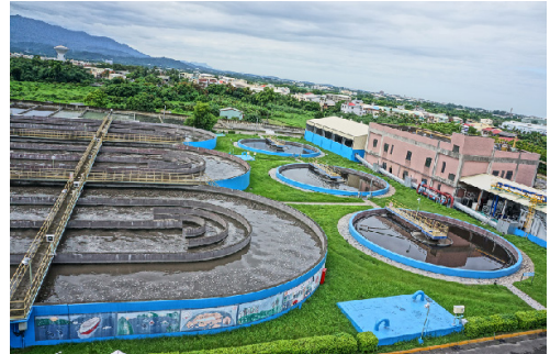
氧化渠及二沉池
