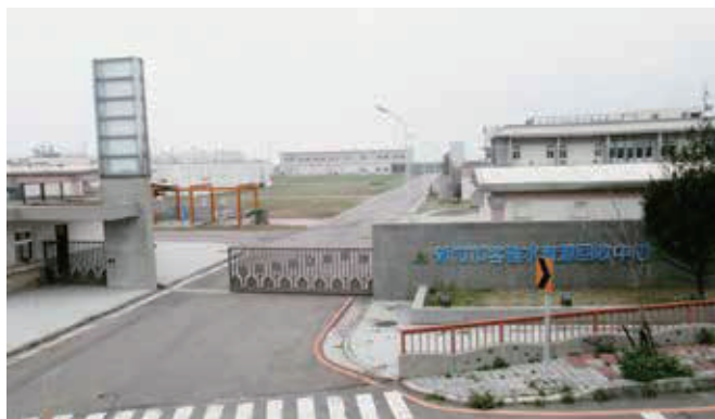
寬廣的天空一望無際與污水廠的設施
