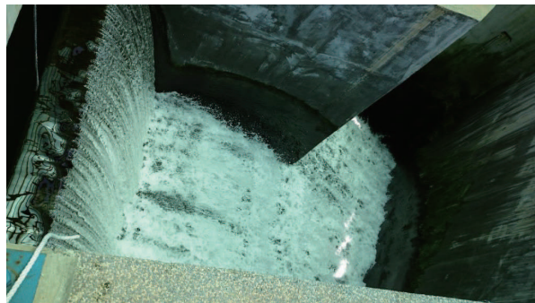
水力發電機組
