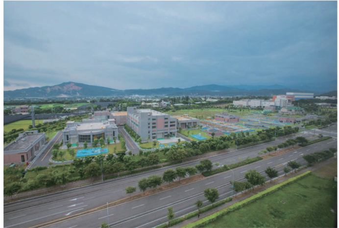
中科后里園區污水處理廠
