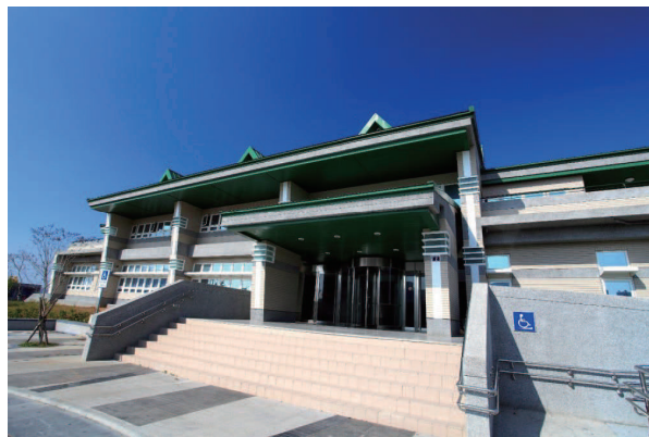
銅級綠建築-操控中心
