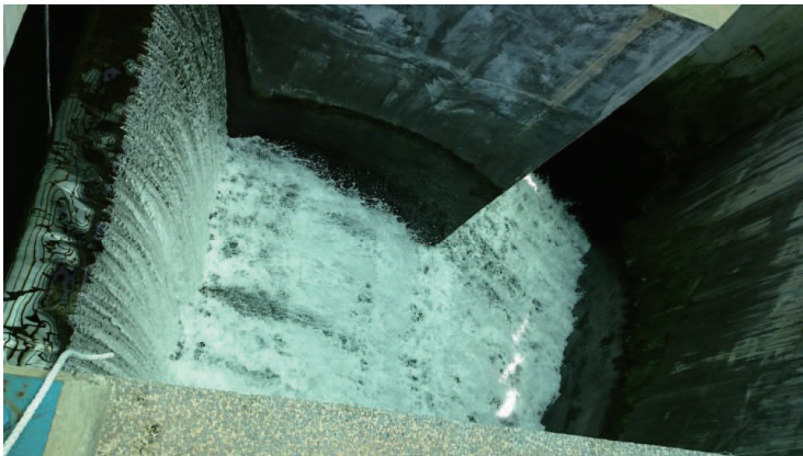
水力發電機組
