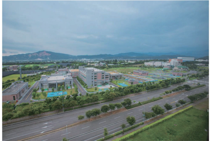
中科后里園區污水處理廠
